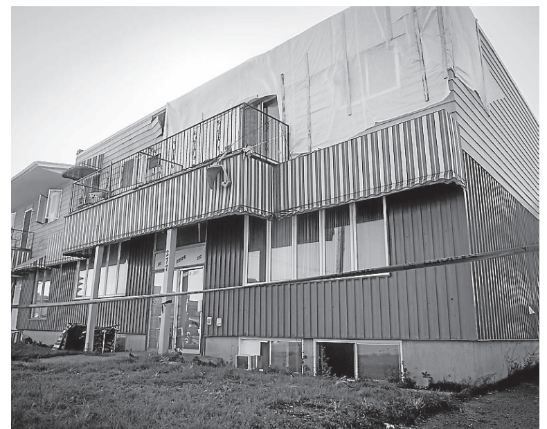
Cet édifice à logements du boulevard Sainte-Madeleine à Trois-Rivières a été lourdement endommagé par un incendie dimanche. — PHOTO: FRANÇOIS GERVAIS
