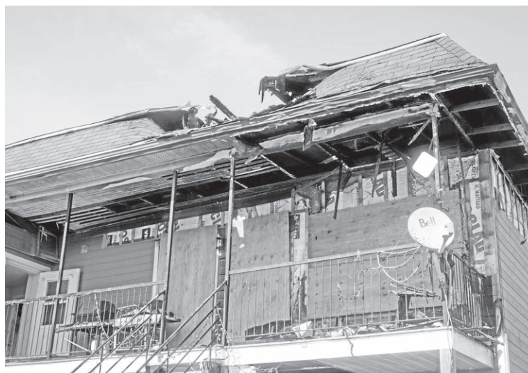
Le feu a lourdement endommagé le logement du locataire concerné, et trois autres logis ont subi des dommages surtout reliés à l'eau. — PHOTO: FRANÇOIS GERVAIS
