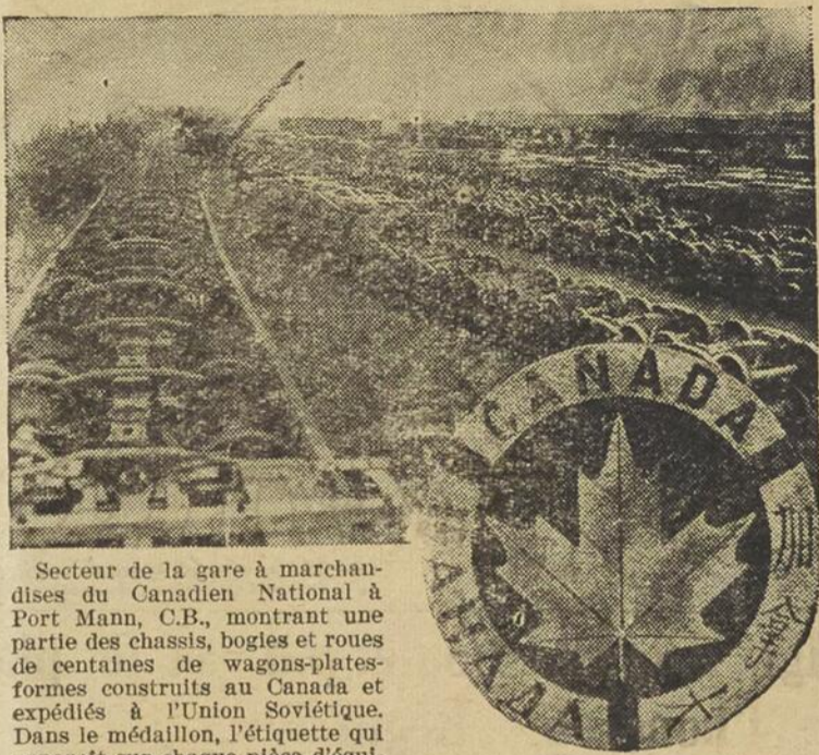
Secteur de la gare à marchandises du Canadien National à Port Mann, C.B., montrant une partie des chassis, bogies et roues de centaines de wagons-plates formes construits au Canada et expédiés à l'Union Soviétique. Dans le médaillon, l'étiquette qui apparaît sur chaque pièce d'équipement. Autour de la feuille d'érable le nom de notre pays est répété en russe et en chinois.
