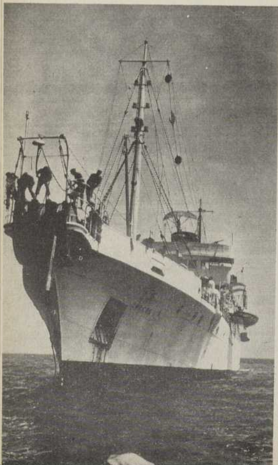
"L'AMPERE" AU TRAVAIL DE POSE DU CÂBLE MARSEILLE-ALGER EN PLEIN OCEAN.
