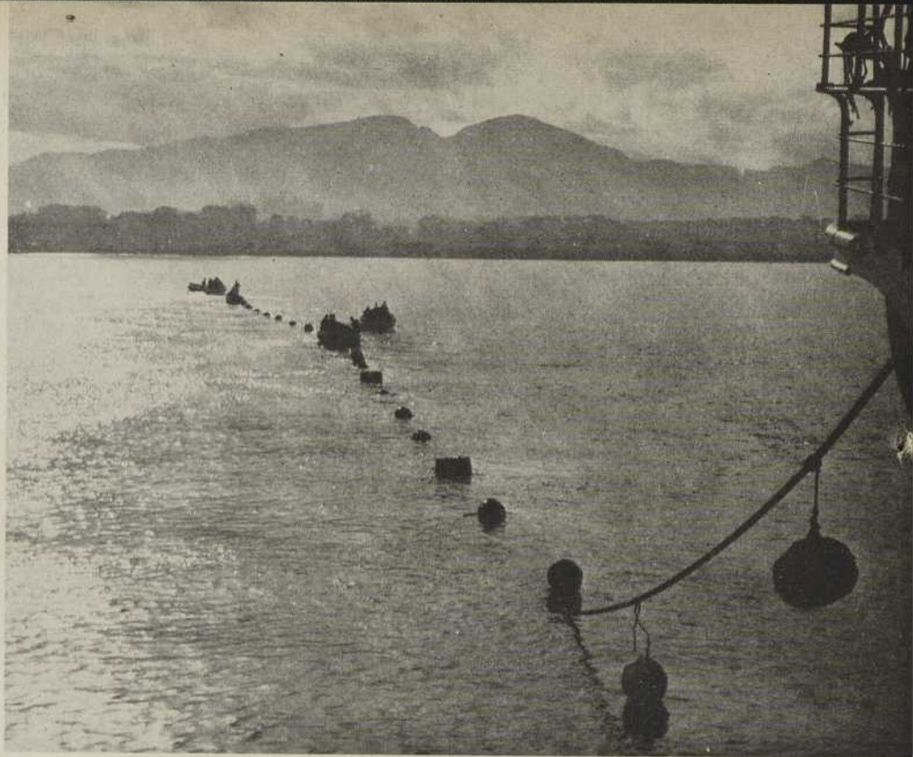
ATERRISSAGE DU CÂBLE PRES DE MARSEILLE.
