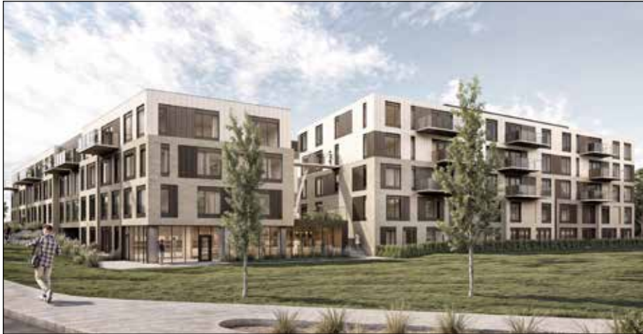
Un tout nouveau projet de construction de 136 logements verra le jour au cours des 18 prochains mois, avec une fin des travaux prévue au mois de juin 2026.
