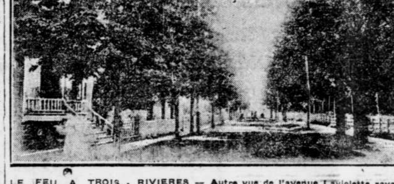
LE FEU A TROIS-RIVIERES — Autre vue de l'avenue Lavolette ravagée par l'incendie.
