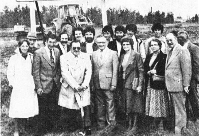
Le maire de Berthierville, M. Jude Guévremont, a procédé à la toute première pelletée de terre, premier pas menant à l'ouverture, le printemps prochain, d'un nouveau centre de rénovation dans la ville. M. Roland Caron, de Berthierville, et M. Patrick Morin, de Sainte-Marcelline, les deux artisans de cet investissement qui dépassera fort probablement le million de dollars, ont assisté à ce geste symbolique. Etaient aussi présents plusieurs membres des familles Caron et Morin, de même que les conseillers municipaux Jean-Claude Guévremont et André Deschenaux.
