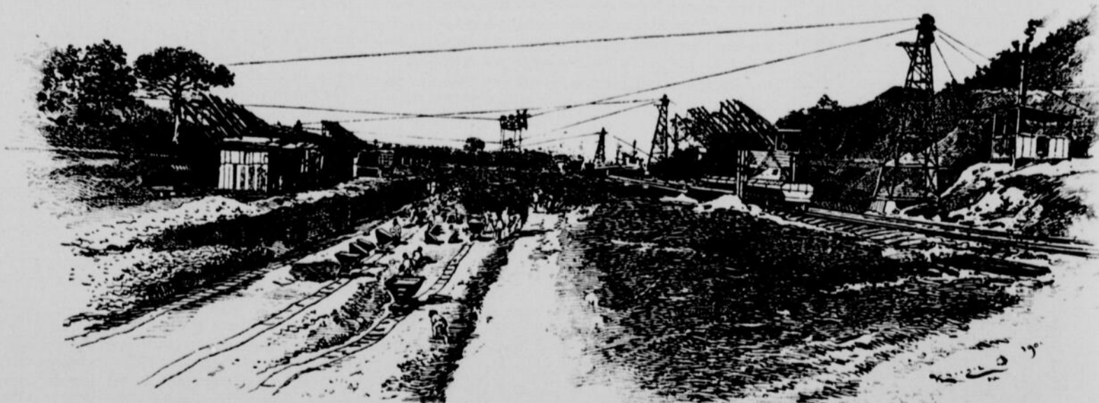
Le travail au moyen des transporteurs aériens dans les chantiers d'Emperador.
