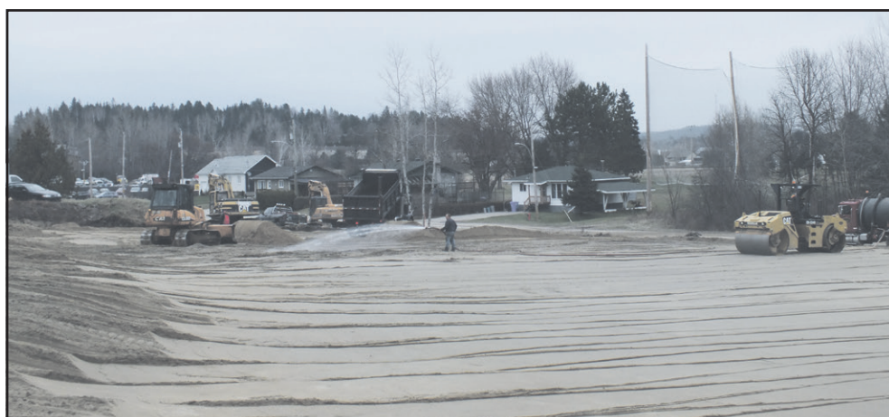
▲ Les travaux consistent pour le moment à préparer le terrain en attendant de commencer la construction au printemps.
