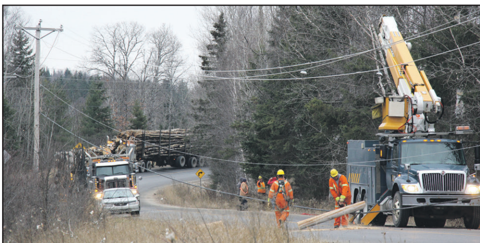
▲ Les agents d'Hydro-Québec sont intervenus pour rétablir l'électricité.
