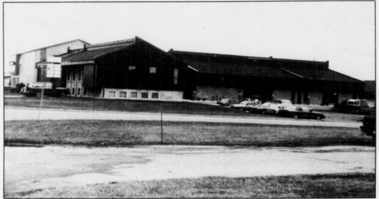
Avec les derniers travaux de juillet, l'immeuble a triplé sa superficie depuis sa construction en 1981. On y retrouve maintenant 11 000 pieds carrés de plancher.
