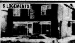
299 à 309 N-DAME O. VICTORIAVILLE Edifice comm. possédant plusieurs revenus.
