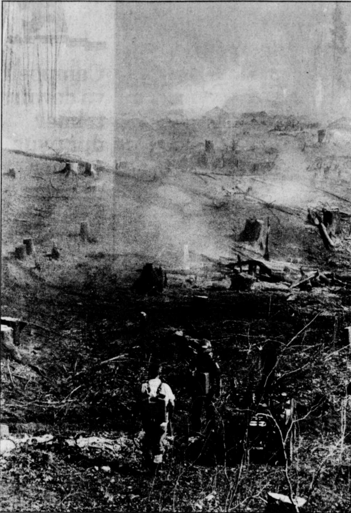
Scène de désolation captée hier après-midi dans le secteur du boulevard Talbot, là où le déboisement pour la nouvelle route a commencé. Ce sont les pompiers de Charlesbourg qui ont eu à lutter contre les flammes qui faisaient rage à cet endroit.
