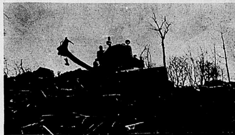
Cette photo ne donne qu'une faible idée des travaux formidables qu'on vient d'exécuter au monte-pente. Fernand Delhaes qui s'est improvisé contremaître pour la circonstance pourrait en dire quelque chose! Il ne faudra pas manquer le spectacle à la première bordée de neige.
