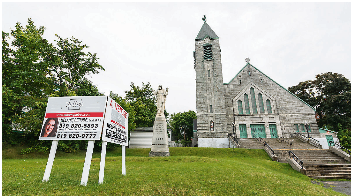
La conseillère de l'arrondissement du Mont-Bellevue Nicole A. Gagnon ignore si les éventuels acheteurs de l'église Sainte-Jeanne-d'Arc, rue Galt Ouest, veulent raser le bâtiment pour construire un cinéma sur le site ou conserver la structure en l'adaptant à sa nouvelle vocation. — PHOTO SPECTRE MÉDIA, FREDÉRIC CÔTÉ
