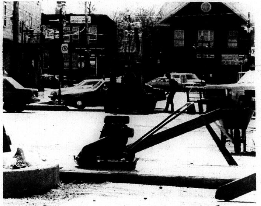
Des passages piétonniers en briques ont été installés cette semaine sur la célèbre Place du Marché.
