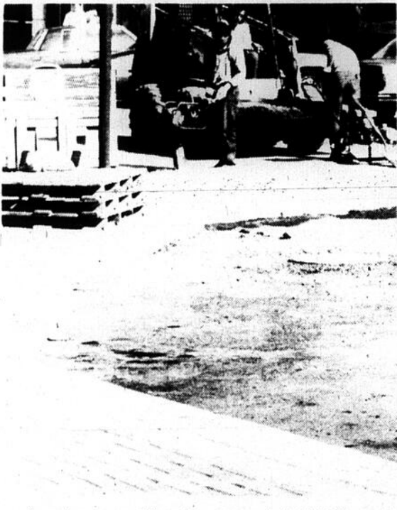
Les travaux d'aménagement de la Place du Marché achèvent. Ils ne restera plus que la pose d'une autre couche d'asphalte. (Photos François Melillo)
