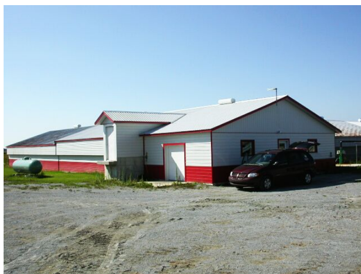
Figure 6. Vue de l'extérieur du site no. 3.
