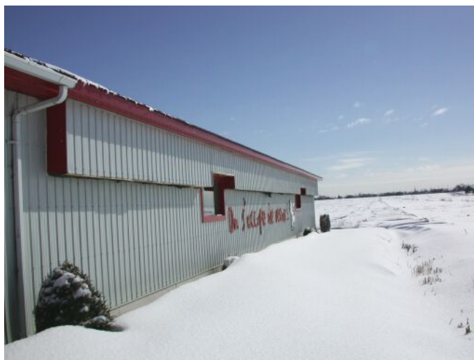
Figure 4. Vue de l'extérieur du site no. 2.
