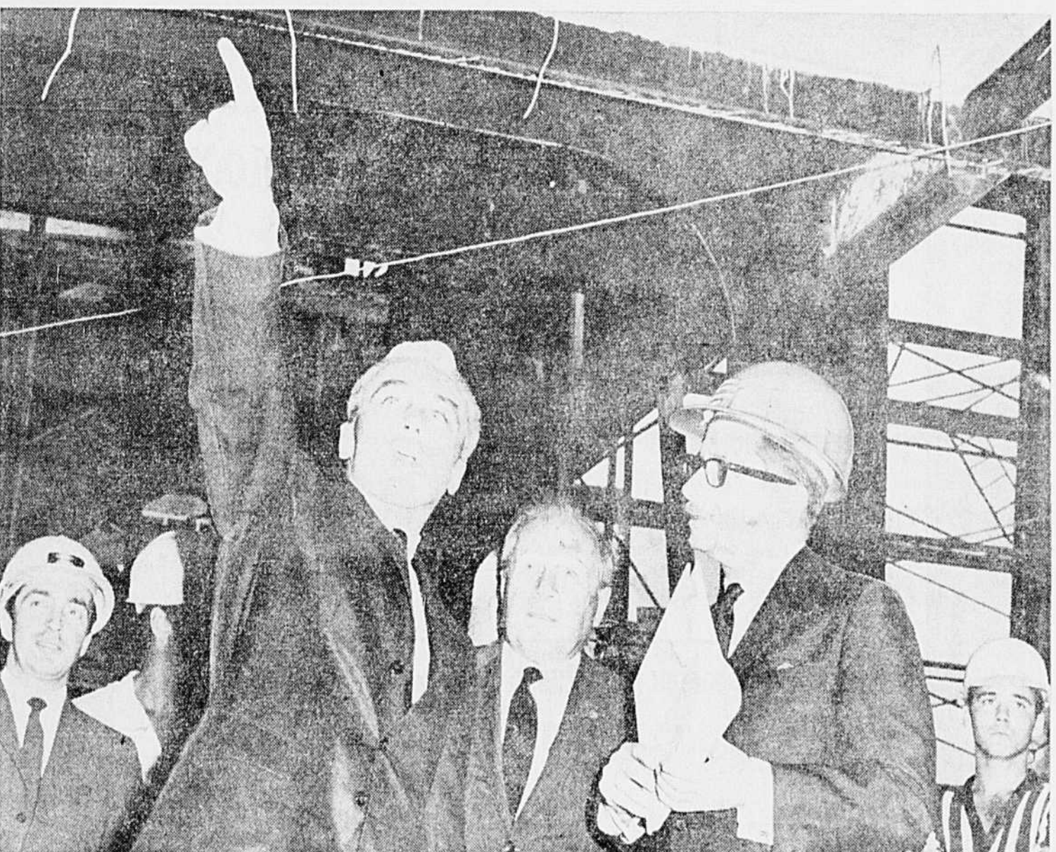
M. Jean Oiseau, commissaire général du pavillon du Québec à l'Expo 67, donne quelques explications sur l'état des travaux à MM. Pierre Dupuy et Daniel Johnson.
