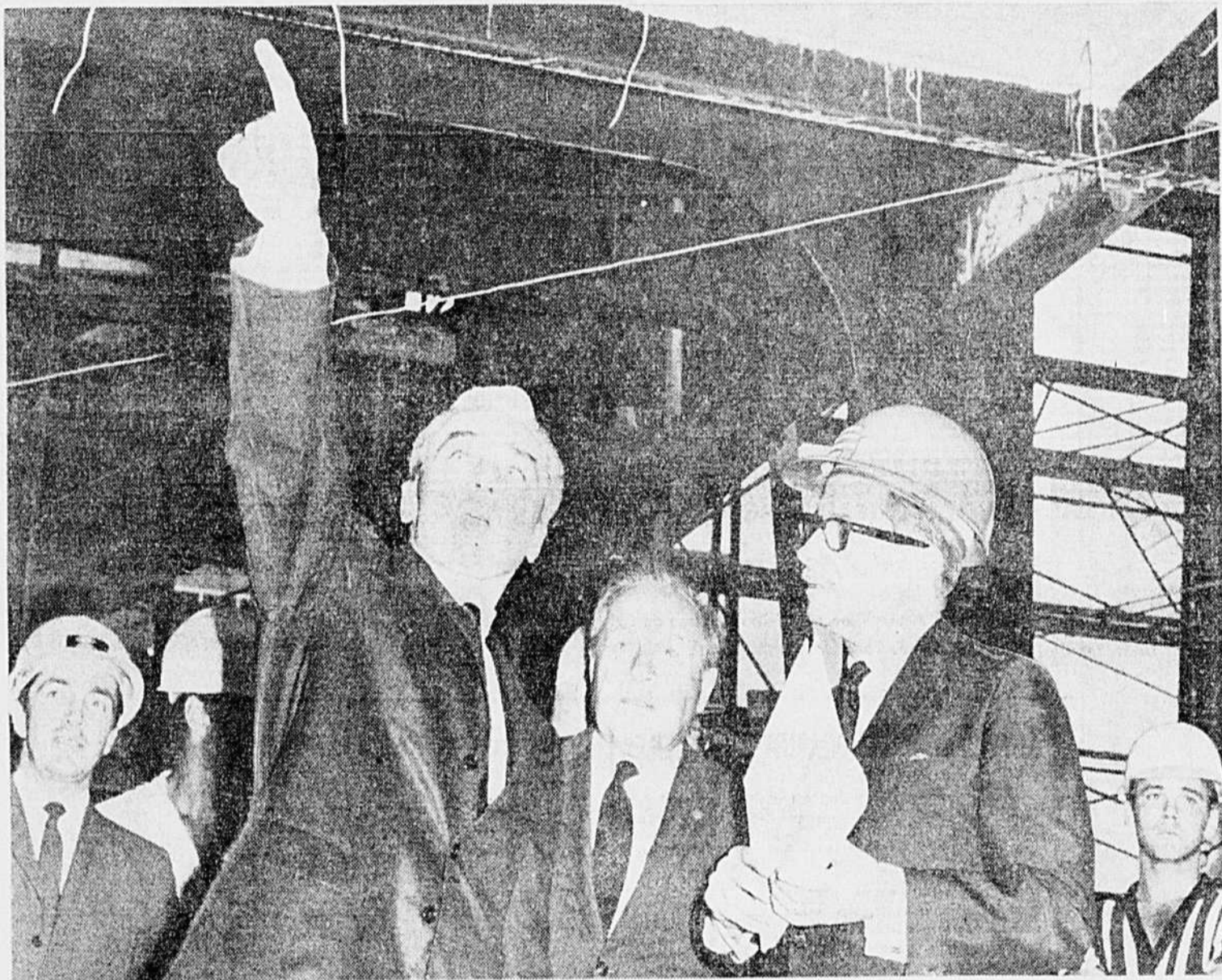
M. Jean Océan, commissaire général du pavillon du Québec à l'Expo 67, donne quelques explications sur l'état des travaux à MM. Pierre Dupuy et Daniel Johnson.
