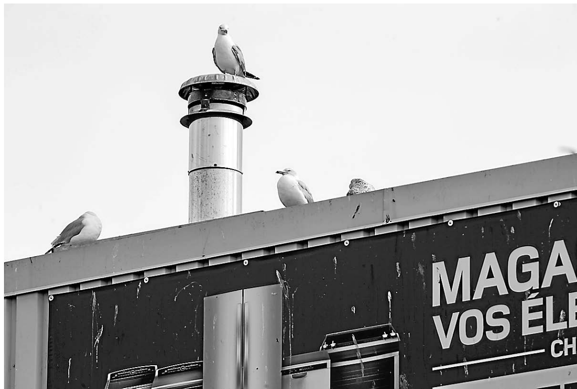
Dès la mi-août, les nids devraient être déplacés et un système de grillage sera installé sur le toit du commerce.
