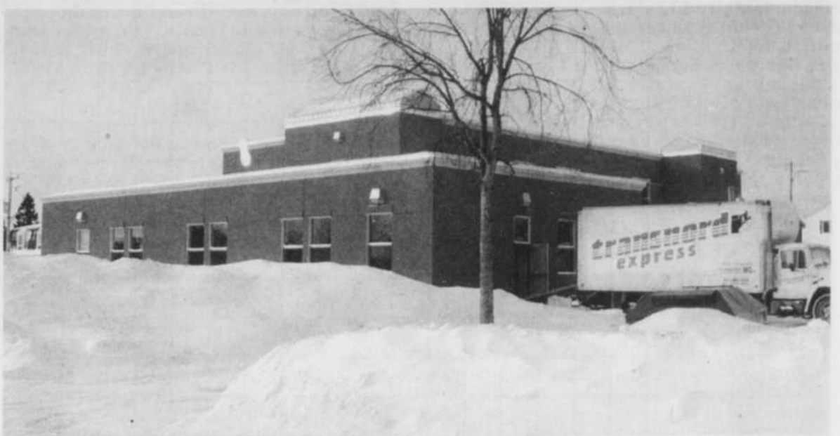
RÉNOVÉ — Voici le nouveau Centre La Mennais, en majeure partie rénové, et partiellement reconstruit. Le stationnement officiel est maintenant situé près de l'entrée principale, plutôt qu'à l'arrière de la bâtisse.
