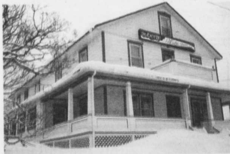
AUBERGE- L'auberge La Coulée Douce à Causapsal.
