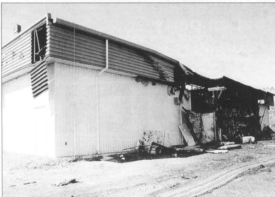
DOMMAGES - La partie entrepôt du commerce Tout en Party de Chicoutimi a été la proie des flammes dans la nuit de dimanche à hier. Les pompiers de Chicoutimi ont mis deux heures pour contrôler l'élément destructeur et ainsi sauver la partie avant de l'édifice.
