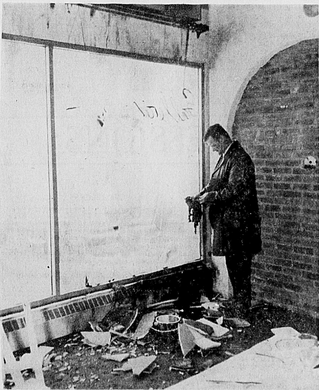
INCENDIE — Le préventiviste Aurélien Lalancette constate les dommages occasionnés, hier, par un incendie qui s'est déclaré, vers 1h., au restaurant "Place Séville" au centre commercial "Place du Saguenay".
