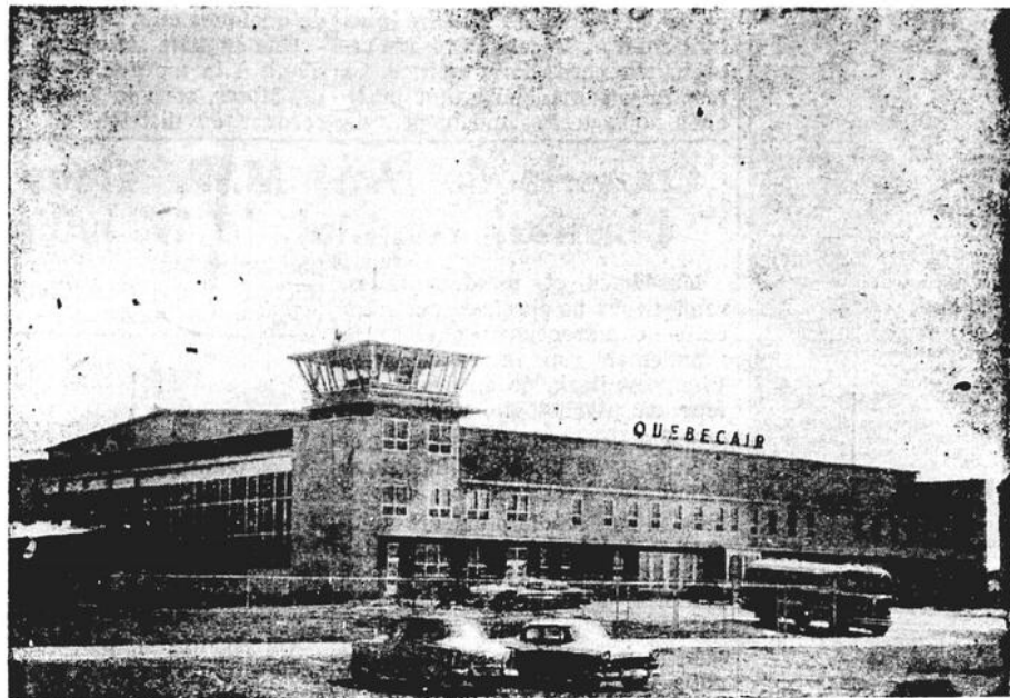
L'aérogare de Québecair avant l'incendie
