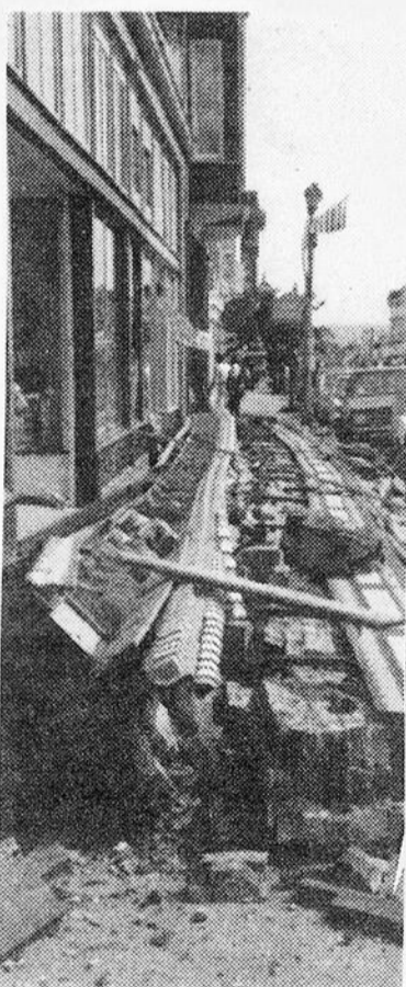
DOMMAGES - Le tremblement de terre qui a frappé le nord de la Californie au cours de la fin de semaine a causé d'importants dégâts dans la localité de Ferndale. Cette rue est quasiment détruite.
