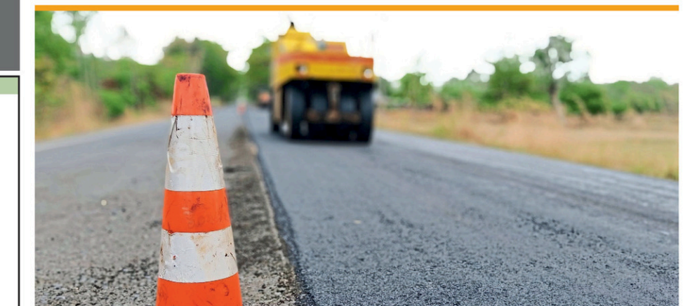
Travaux d'asphaltage à Saint-Georges (Photo libre de droits - Pixabay)
