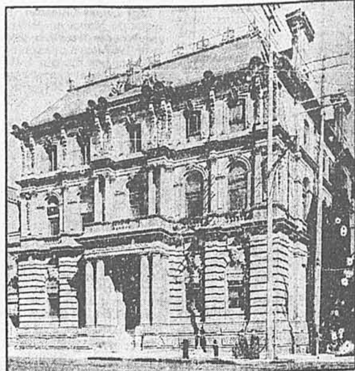
Le siège social de la Banque Molson après l'installation de l'électricité.
