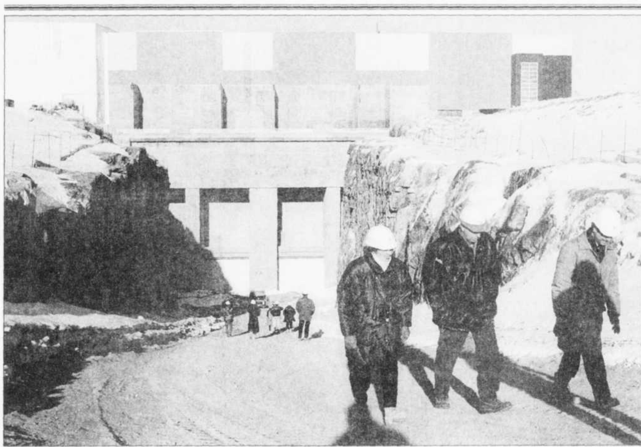
La centrale Laforge-2 est complètement à sec. On voit ici, tout en bas de la photo, les deux sorties d'eau qui seront éventuellement inondées.
