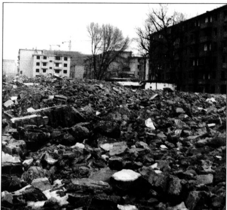
Plusieurs vieux édifices sont démolis.
