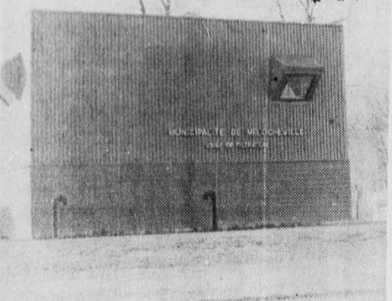
L'Usine de Filtration de Melocheville, dont la capacité peut accommoder une population de 5,000 de population.
