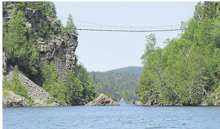
La passerelle suspendue du parc national d'Aiguebelle. — PHOTO LA TRIBUNE, ISABELLE PION
