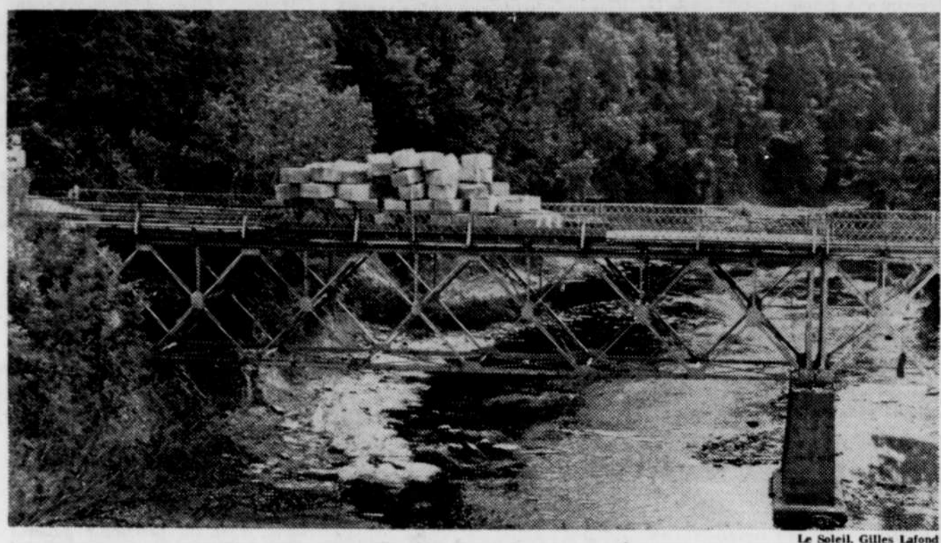
142 blocs d'une tonne et trois quarts chacun ont été empilés sur le côté est du pont Noir, depuis jeudi dernier.
