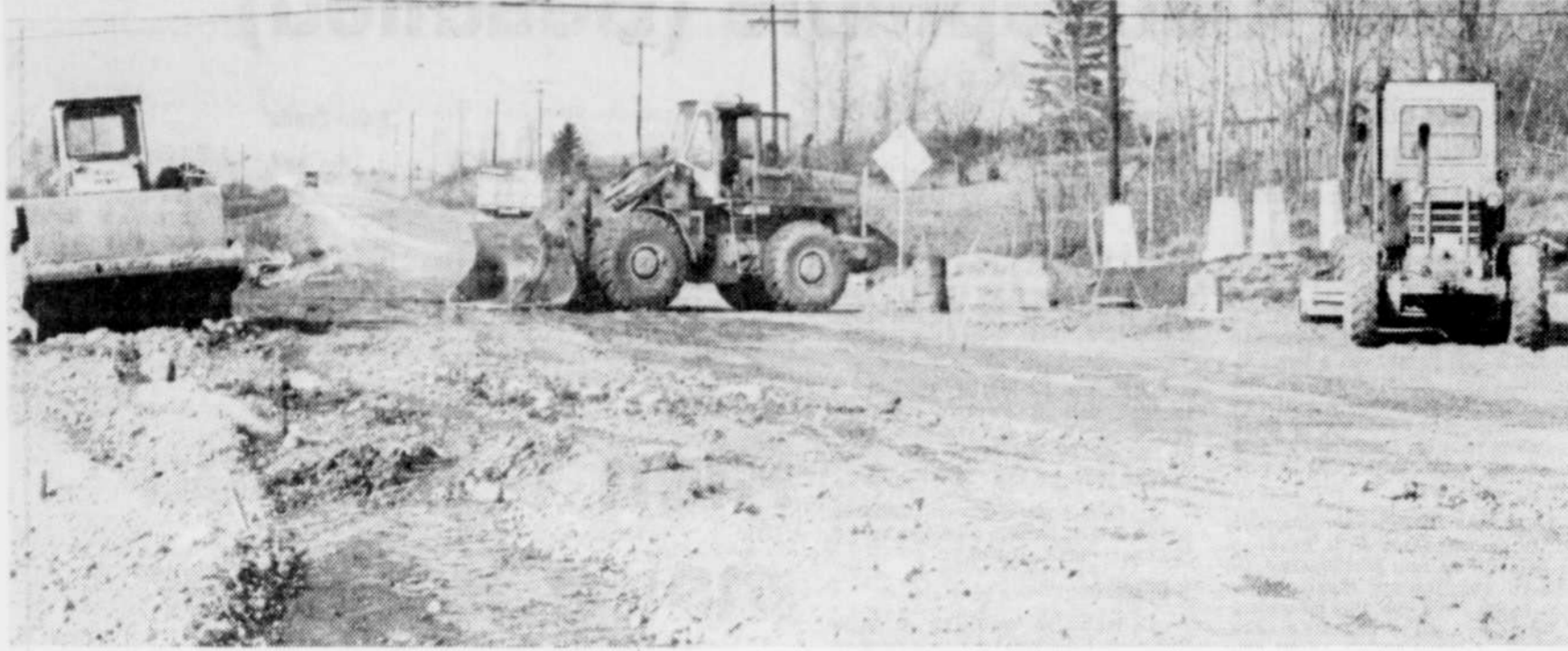
Les travaux seront complétés à 95 pour 100 dès l'hiver prochain.
