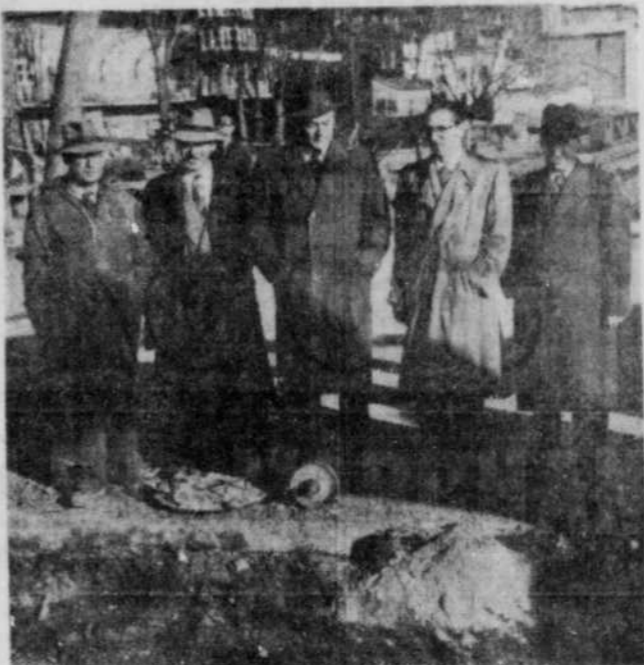
TRAVAUX D'EXCAVATION, EXECUTES AVEC DILIGENCE. — La Bosco Construction, dont le propriétaire est M. Eugène Bélanger, de Magog, a exécuté avec une rapidité extraordinaire des travaux d'excavation, qui exigent des manoeuvres une rapidité accrue. Ils n'avaient que trois heures pour passer les canalisations d'aqueduc sous la voie ferrée de la rue Merry, propriété du Pacifique Canadien. La tâche a été terminée dans le temps convenu. Mais il a fallu que les manoeuvres fassent vite. On voit ici, de gauche à droite, MM. Eugène Bélanger, propriétaire de la Bosco Construction, M. Raoul Cabana, propriétaire de la Cabana Construction, sous-entrepreneur des travaux d'aqueduc en cours, M. Jacques Lemieux, ingénieur, M. Roger Boudreau, secrétaire-trésorier de la cité de Magog et Son Honneur le maire de Magog, M. Ovide Bergeron, qui ont surveillé l'opération. (Photos: R. Courtemanche, Magog)
