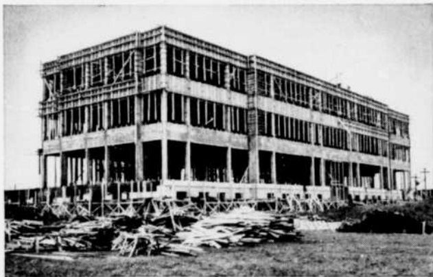
Du béton "ajouté" de Chlorure de Calcium Brunner Mond a été utilisé pour la construction de la nouvelle Ecole Vétérinaire Provinciale à Saint-Hyacinthe, province de Québec. (Terminée l'été de 1953)
