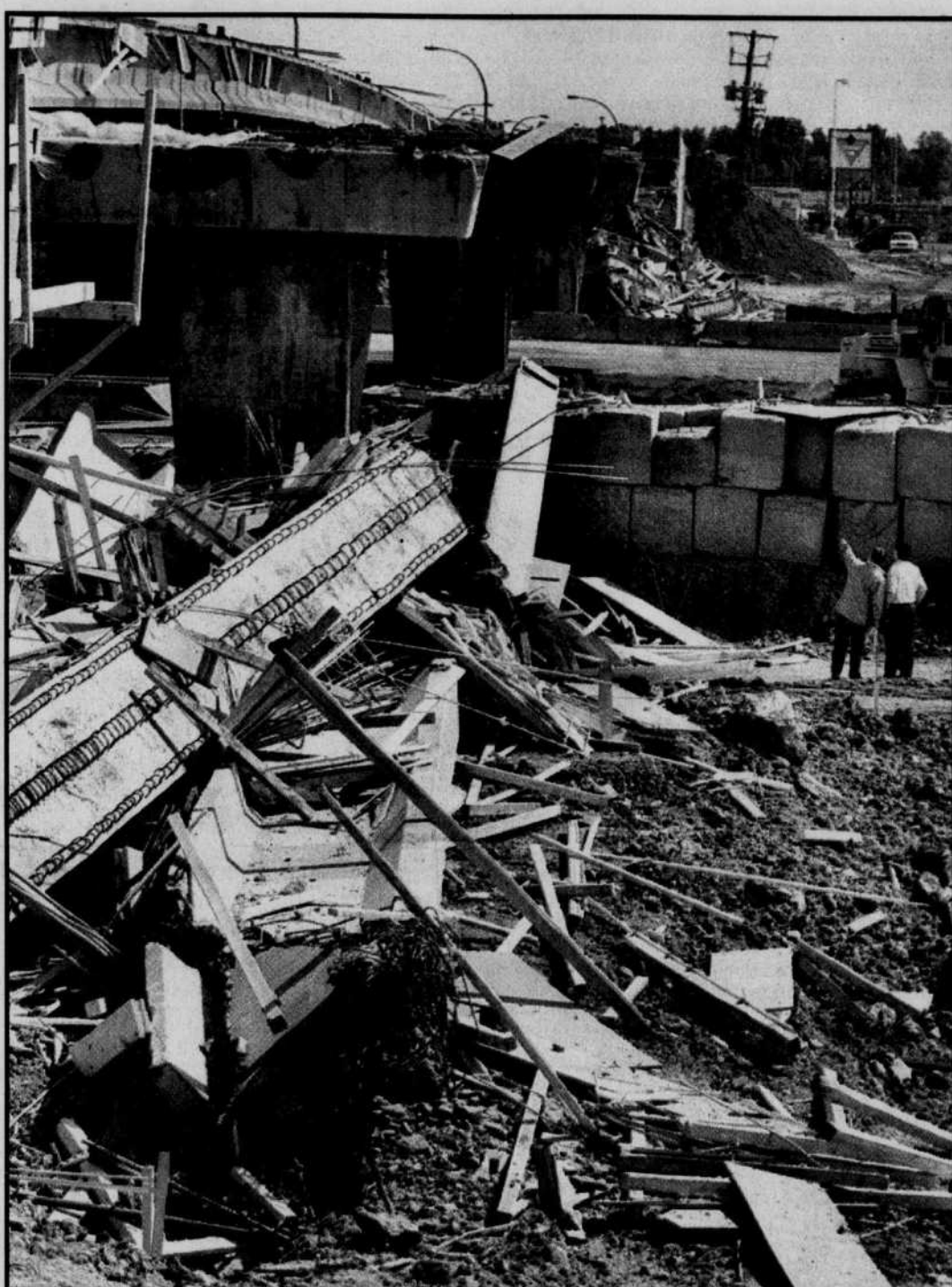
Des enquêteurs s'affairaient hier à étudier les causes de l'effondrement du viaduc du boulevard du Souvenir.
