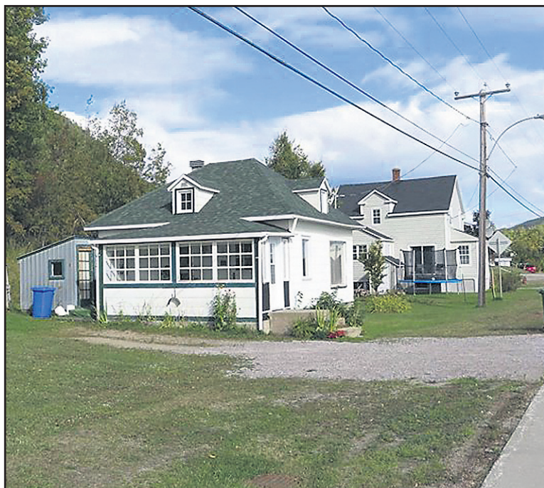
Voilà la résidence où moine Joseph a implanté son ermitage, du côté de l'entrée ouest de Franquelin. Photo courtoisie
