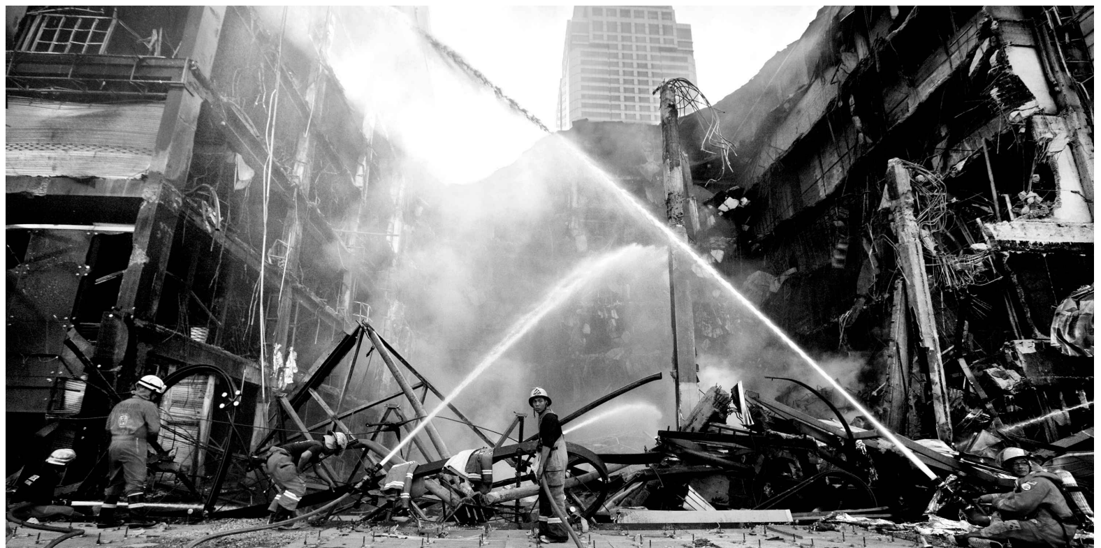
Des pompiers éteignent le feu qui couvrait encore dans le centre commercial Central World, dont les ruines menacent de s'écrouler. — PHOTO REUTERS
