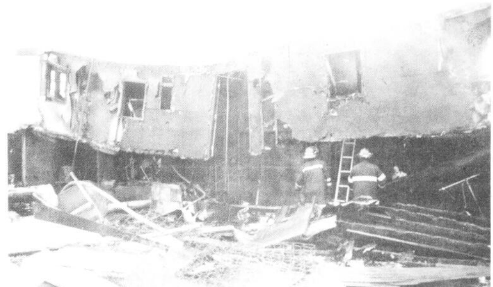
...Mais lorsqu'on regarde la partie arrière, on ne peut que constater l'ampleur des dommages.
