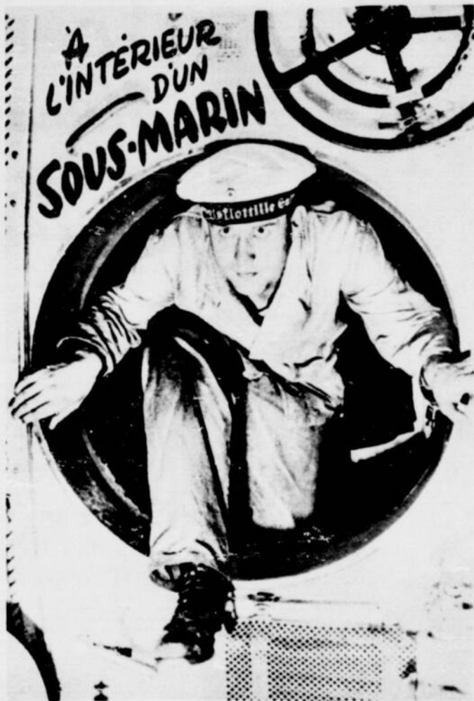
Un marin sort de la chambre aux torpilles. L'ouverture, qu'il utilise se referme hermétiquement. Au cas d'accident à la proue, on tire cette porte qui empêche l'eau de pénétrer plus loin
