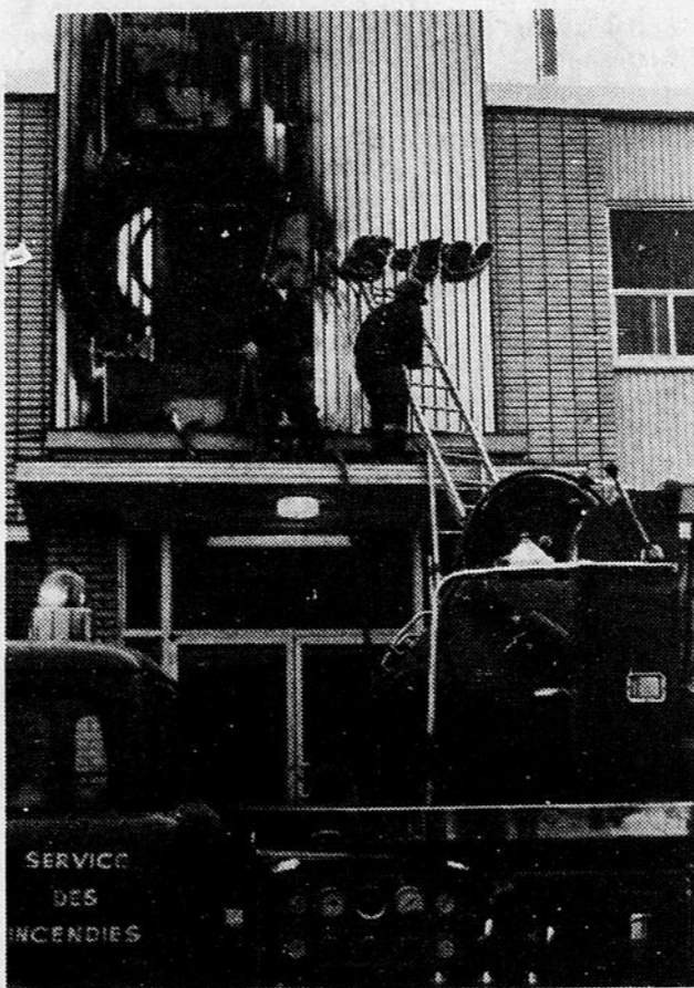
INCENDIE MINEUR — Un incendie mineur vraisemblablement consécutif à une défectuosité dans le système électrique, a pris naissance tôt hier matin dans l'enseigne d'identification de la station CKRS télévision, à Jonquière. Les pompiers ont rapidement circonscrit les flammes, les dommages paraissent mineurs.
