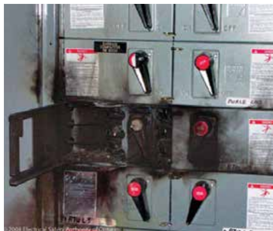
PHOTO: ELECTRICAL SAFETY AUTHORITY OF ONTARIO La victime a subi des brûlures au 2 e et 3 e degré au cou, au visage et aux mains suite à un mauvais branchement dans le multimètre.
