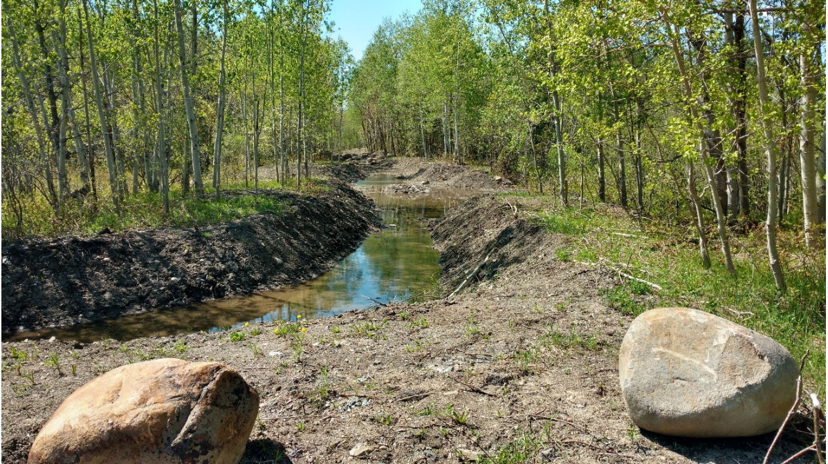
Photo 3 Tronçon TW-2, excavation dans la terrasse de 13 m (photo Nicolas Fortier)
