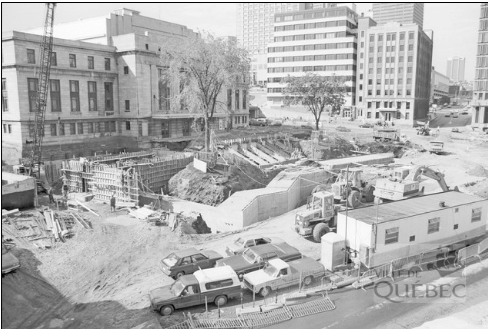
Figure 112 Construction de la place D'Youville, 1987 (AVQ Q-C5-IC-N028988)
