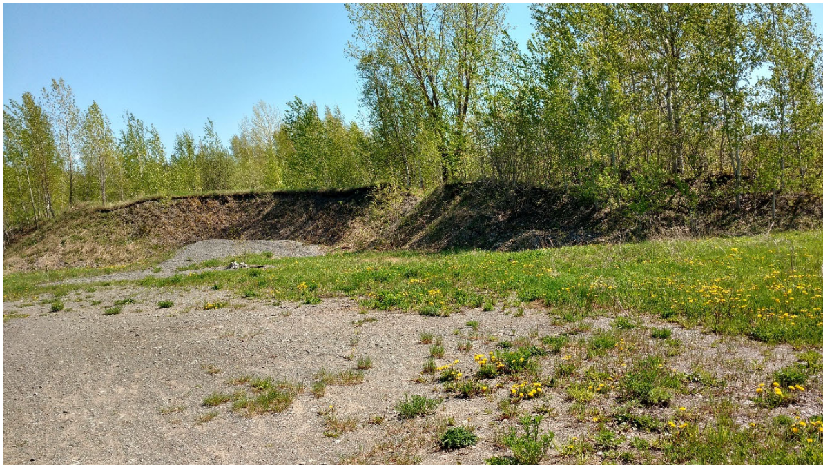
Photo 2 Tronçon TW-2, excavation dans la terrasse de 30 m (photo Nicolas Fortier)
