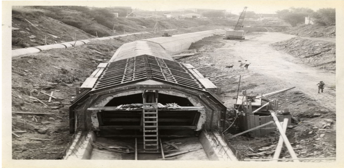
Figure 83 Canalisation de la rivière Lairet à la hauteur de la rue Cadillac, 1967 (BAnQ 03Q_P428S3SS1D38P14)
