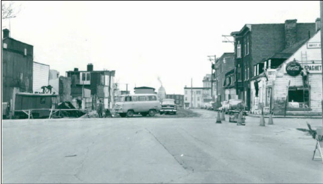
Figure 27 Travaux d'élargissement de la rue Plessis, 1962 (AVQ Q-C1-14-N006073)
