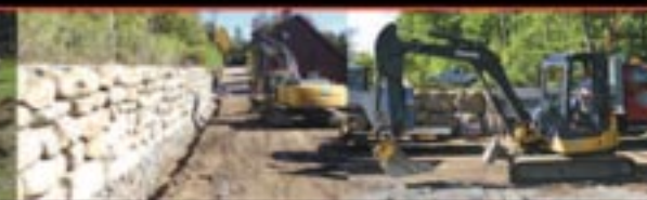
MUR DE SOUTÈNEMENT
