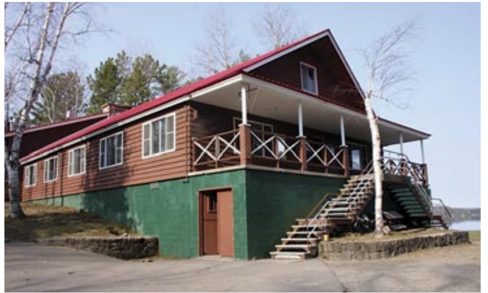
Le nouveau réfectoire reconstruit à la suite de l'ancienne destruction par le feu.
