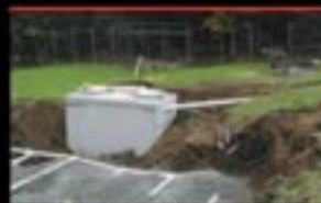
INSTALLATION DE FOSSE SEPTIQUE
