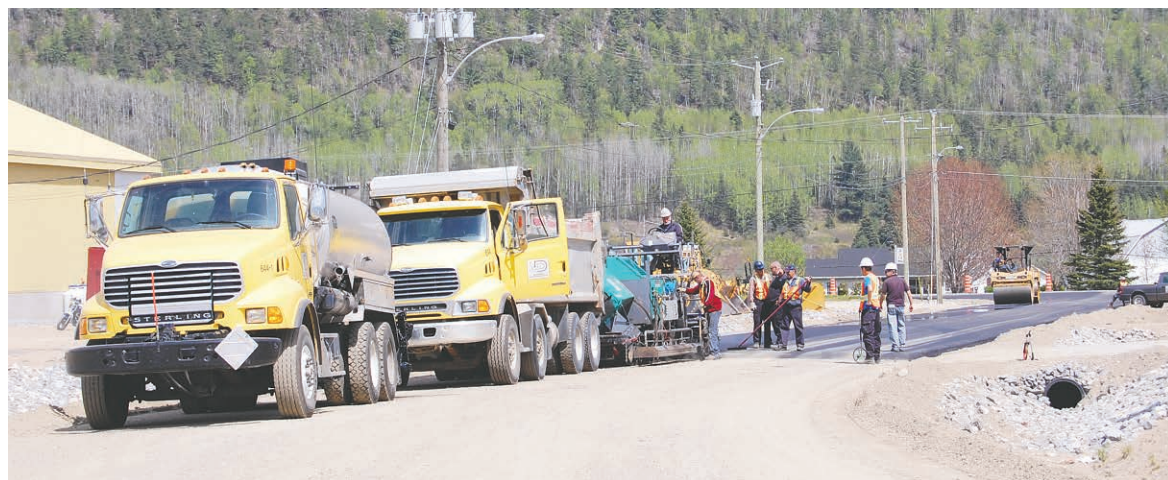
Des travaux routiers auront bientôt lieu à Saint-Aimé-des-Lacs. Photo archives
