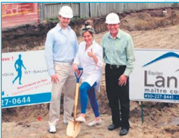
LE CHANTIER DE CONSTRUCTION DÉBUTE LE 31 MAI 2013
