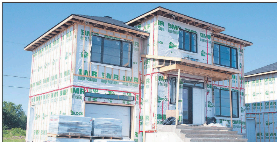
Neuf résidences unifamiliales ont été mises en chantier à Saint-Jean-sur-Richelieu en septembre 2019.
