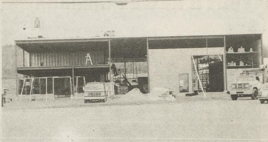
Le futur entrepôt de Bolduc et Fils est présentement en construction sur le boul. Taché ouest.
