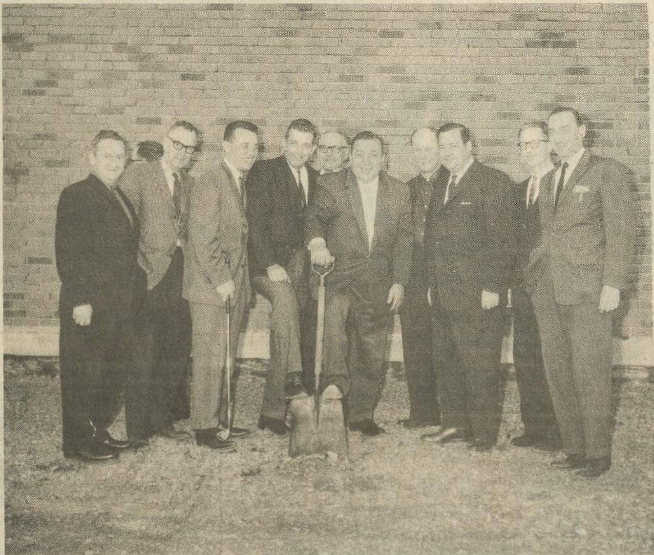
La levée de la première pelletée de terre qui devait conduire à la construction du club de curling. On reconnaît Gabriel Lussier, Alex Babin, Réal
