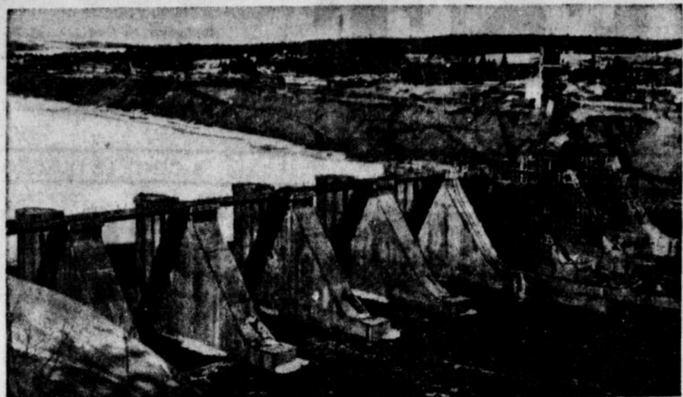
LES TRAVAUX ACHEVENT : — Moins d'un an après le début des travaux sur la rivière St-Jean, au N.-B., à quelque 100 milles de Fredericton, les travaux du barrage de 1.600 pieds construit pour la Commission du pouvoir électrique du Nouveau-Brunswick tire à sa fin. On aperçoit à droite les tours qui restent à terminer, avant les crues d'eau du printemps. (S.N.S.)
