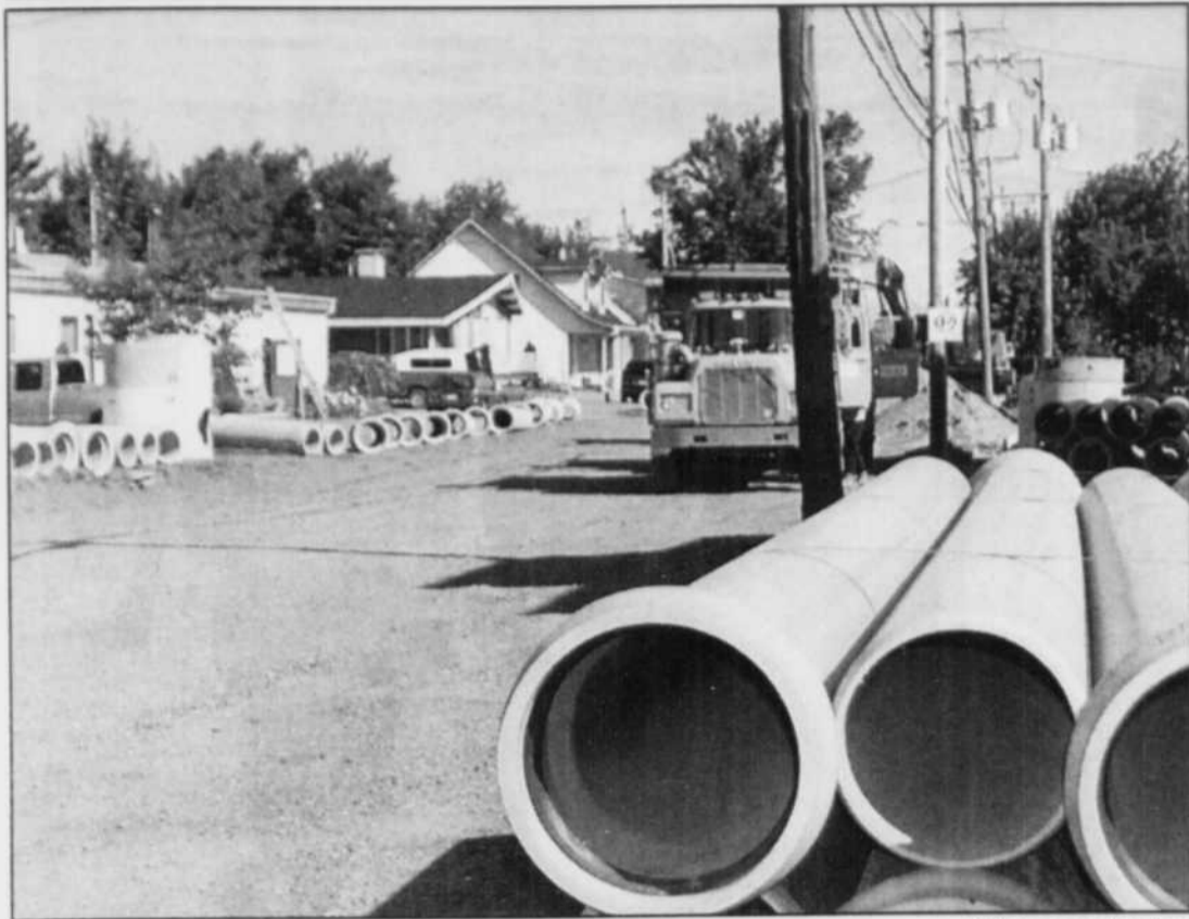
(Photo Marcel Aubry) D'importants travaux totalisant des coûts de 5,2 millions $ sont en cours à Daveluyville depuis la mi-juillet, notamment sur la rue Principale. Ces travaux qui se poursuivront au moins jusqu'à la fin d'octobre, sont exécutés principalement dans le cadre du Programme d'assainissement des eaux municipales (PADEM). La municipalité en profite aussi pour faire d'autres travaux connexes de voirie et d'aqueduc.
