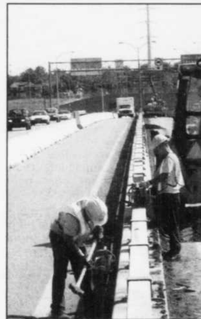
(Image-Média: Patrick Beauchamp) Des travaux se déroulent présentement sur le pont Radisson.
