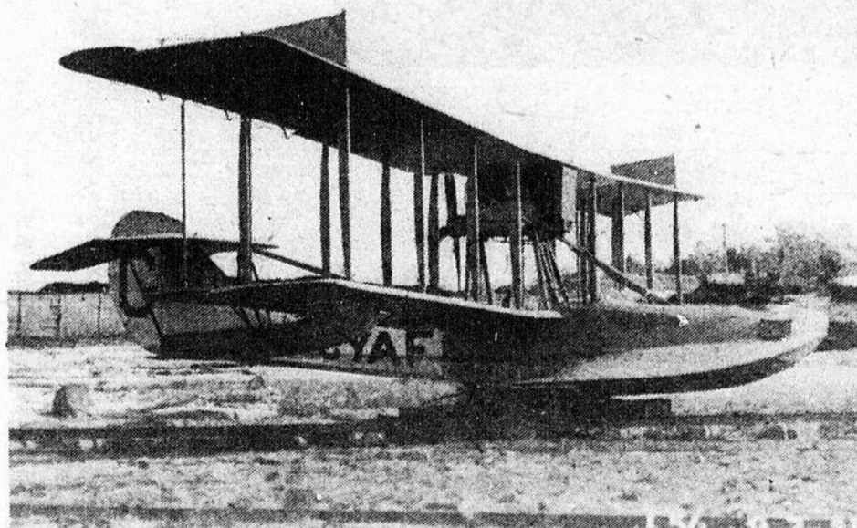
Le CYAF est sur un charriot, lequel à son tour est sur des rails de chemin de fer. On distingue bien le radiateur à l'avant et l'hélice à l'arrière.
