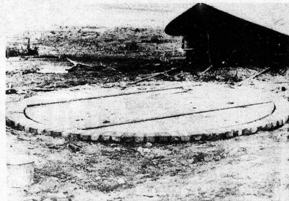
LE TOURNIQUET sur lequel un homme pouvait tourner un avion dans nombre de positions pour le travailler.
