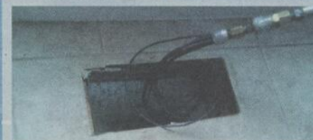
Avec cette brosse on enlève la poussière qui sera aspirée par le capteur. Avec ce traitement. Le conduit restera propre pour 5 à 10 ans.
