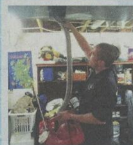
Avec cet appareil, on pulvérise un décontaminant à l'intérieur de la grille d'aération.
